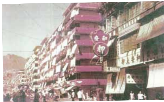
●白田街與巴域街間的七層徙置大廈，約1965年。
