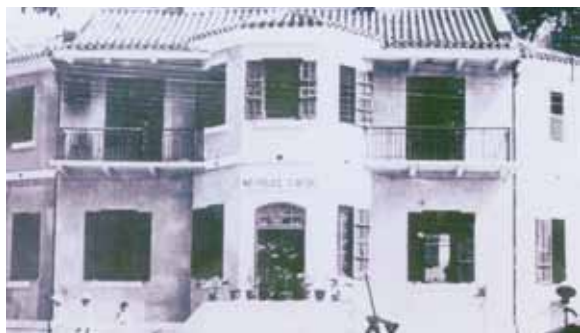
●位於禮頓道，面向波斯富街的一號差館，約1915年。
