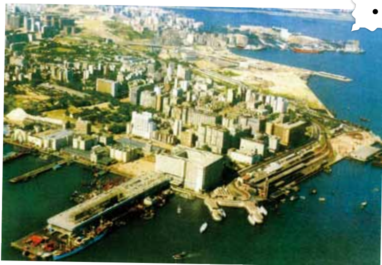
● 正在重建的九龍倉，約1973年。
