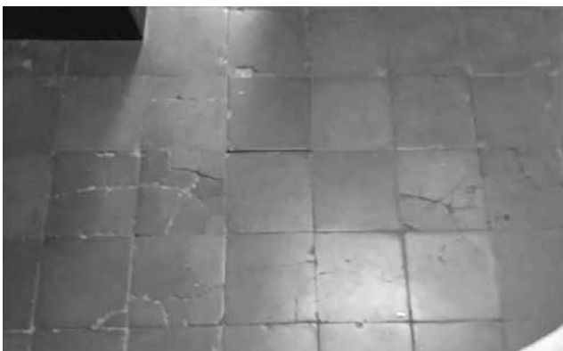
圖左為原本所拱起的瓷磚。經過義工細心維修下，就成為平坦的地面(見右圖)，從此吳婆婆就不再擔心會因瓷磚拱起而絆倒。
